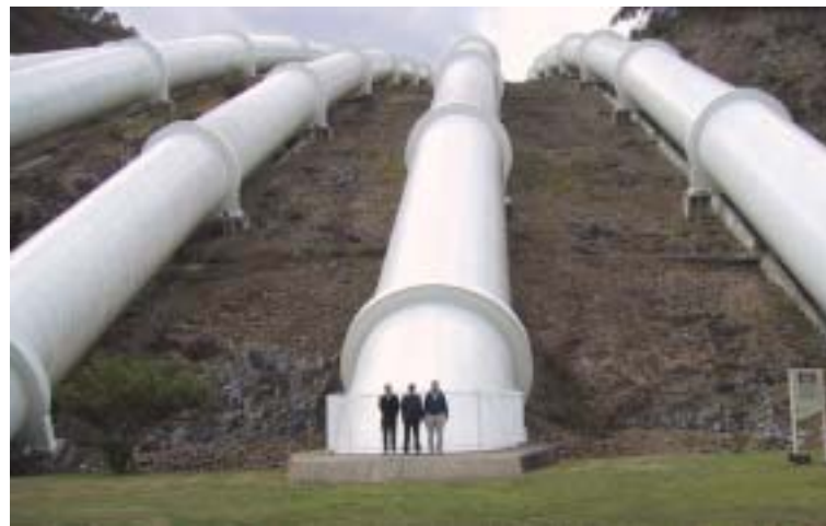
По этим огромным трубам на электростанции «Тумут 3» гидросистемы в Снежных горах подается вода на генераторы для получения электроэнергии.
